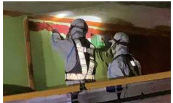
写真-4 跨線橋 軌陸作業車
