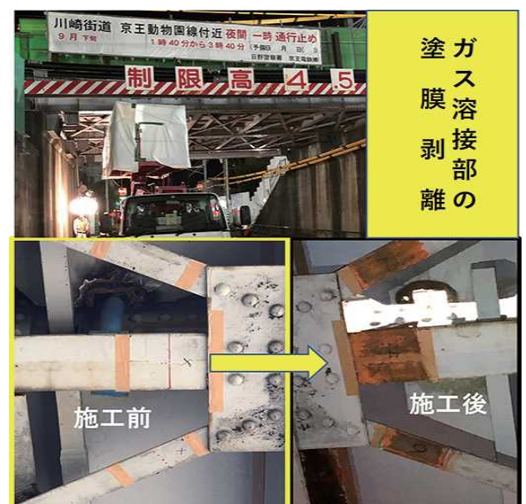
写真-6 鉄道橋 高所作業車
