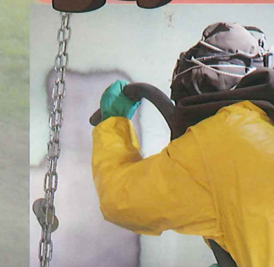
粉じん発生の少ない施工状況
