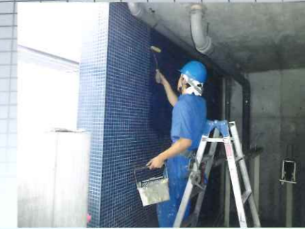
タイル面へのローラーによる施工
