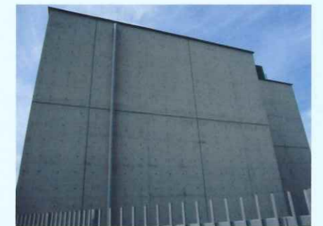
海沿いのコンクリート打ち放し建築物。Sクリートガード®施工後10年経過しているが、クラック・爆裂・黒カビの発生が無く、良い状態を継続しています。
