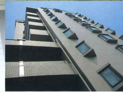
施工後の様子。外観の変化はありません。(※1)
