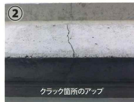
リブ型コンクリートに生じたクラック
