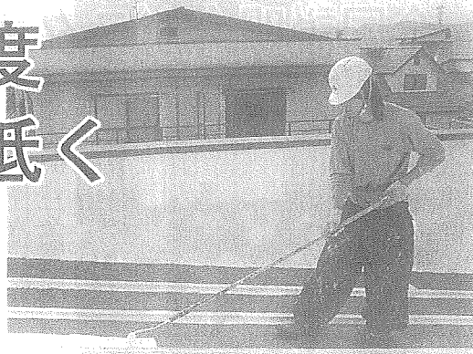
ミラクルの施工風景。屋根に塗るだけで高い遮熱効果を発揮する
